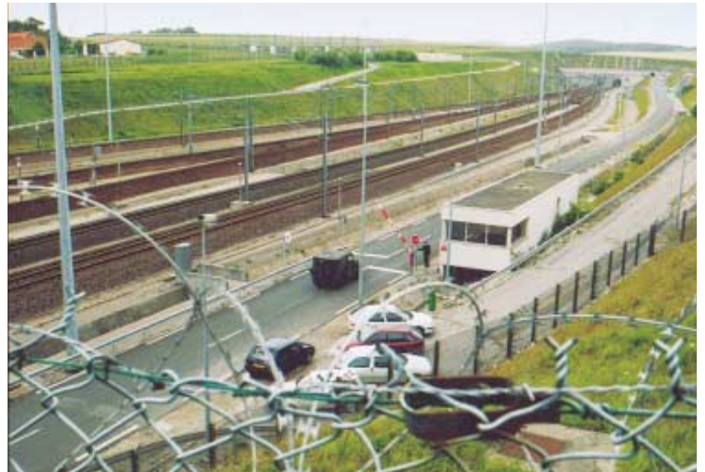
Blick auf den Eingang des Eurotunnels nach Großbritannien (ganz hinten) und die Absperranlagen (Wachschutz, Militärpolizei, Elektrozaun und NATO-Draht)
